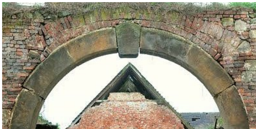
Detail des Baus in Bleesern Foto: kuhn
